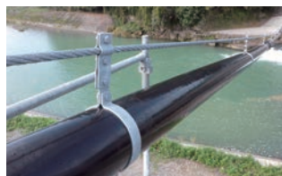
吊りハンガー取付状況
