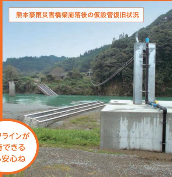
熊本豪雨災害橋梁崩落後の仮設管復旧状況
