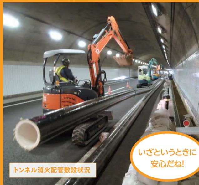
トンネル消火配管敷設状況
