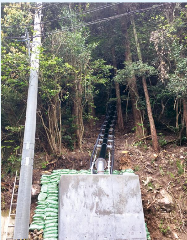
新三大夜景にもあげられる長崎市稻佐山公園の改修工事に伴う、排水管・給水管の布設替工事です。急傾斜50度以上、岩質の凹凸が多い斜面への施工という、極めて困難な現場でした。MESCOパイプの「長尺性」・「可とう性」の特性を活かし、MESCOパイプだからこそ無事施工完了ができた現場でした。 福岡営業所 廣瀬仁巖
