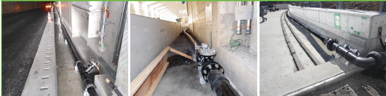
本工事は三郷南IC～高谷JCTの15.5kmの内、京葉道に接続する京葉JCTの6ランプとトンネル部（内外回り）の8トンネルの消火設備用の配水管の布設工事です。
