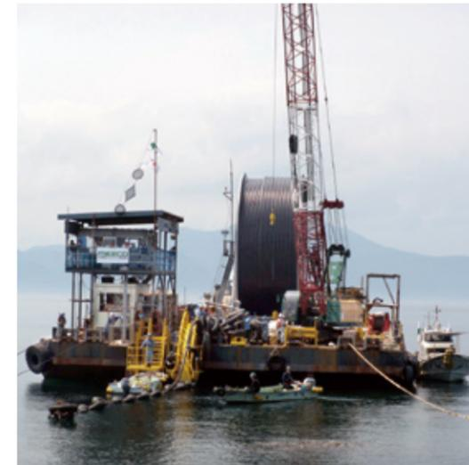
本件は長崎県平戸市の離島、度島への既設海底送水管の老朽化に伴うWNGパイプ100 mmでの更新工事です。施工延長は約 5,350 m で、水深 60 m を超える箇所もあり施工条件の厳しい工事でした。
