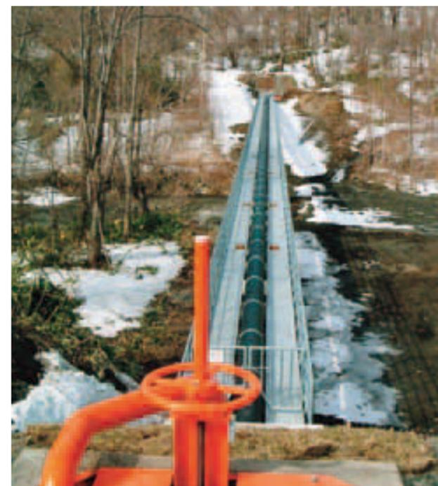
品種:WE21 呼び径:400mm 長さ:110m
