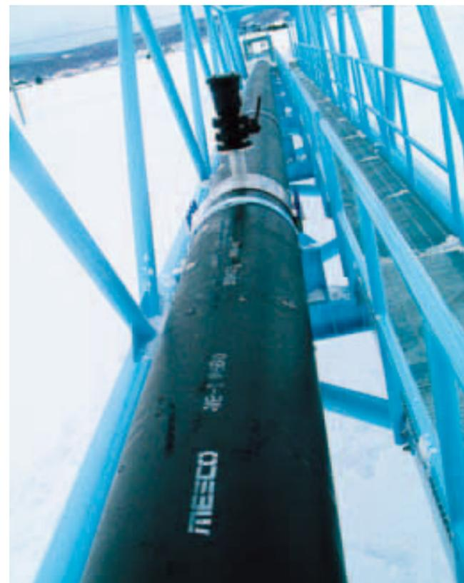
品種:WE21 呼び径:500mm 長さ:41m
